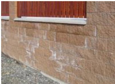
▼ Problém vápenných výkvětů na betonových výrobcích, pokud se jedná o primární výkvěty, nemá vliv na užitné vlastnosti výrobků. Jedná se pouze o dočasnou estetickou vadu. O tom, že výskyt primárních vápenných výkvětů nemá vliv na užitné vlastnosti betonových výrobků, svědčí ten fakt, že výskytem vápenných výkvětů se nezabývá žádná norma a žádný předpis pro betonové výrobky.
