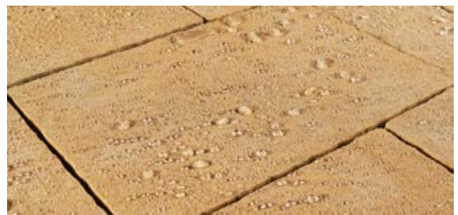
POVRCH DLAŽBY S ÚPRAVOU DEP
