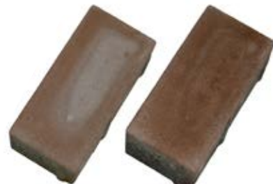
Povrch dlažby s vápenným výkvetom pred čistením a po vyčistení Rebanitem S
