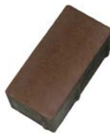
Povrch dlažby bez vápenného výkvětu
