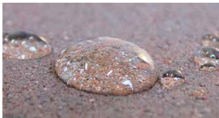
Detail ošetreného povrchu
