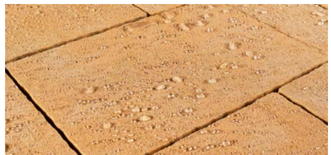
POVRCH DLAŽBY S ÚPRAVOU DEP
