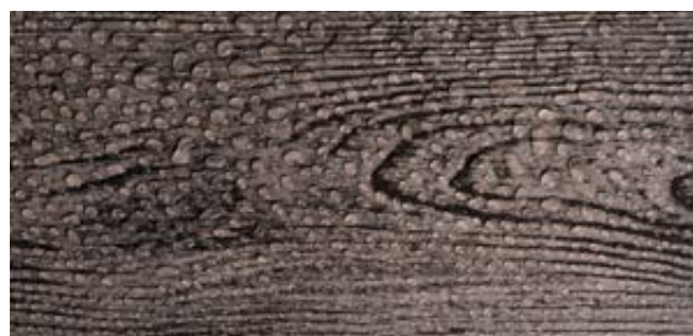
POVRCH DLAŽBY S ÚPRAVOU DEP
